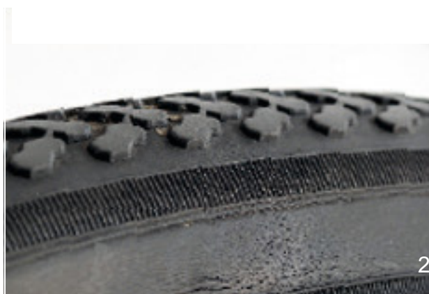
Illustration 204 : Exemples de fissures de fatigue (1) et de fissures d'âge (2)
